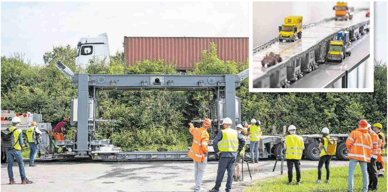
Das erste Portal (oben die abgeklappten Leitplanken) wurde gestern auf einem LKW nach Rothrist transportiert. Rechts ein Lego-Modell der «Astra Bridge»: oben rollt der Verkehr, unten wird gebaut.
