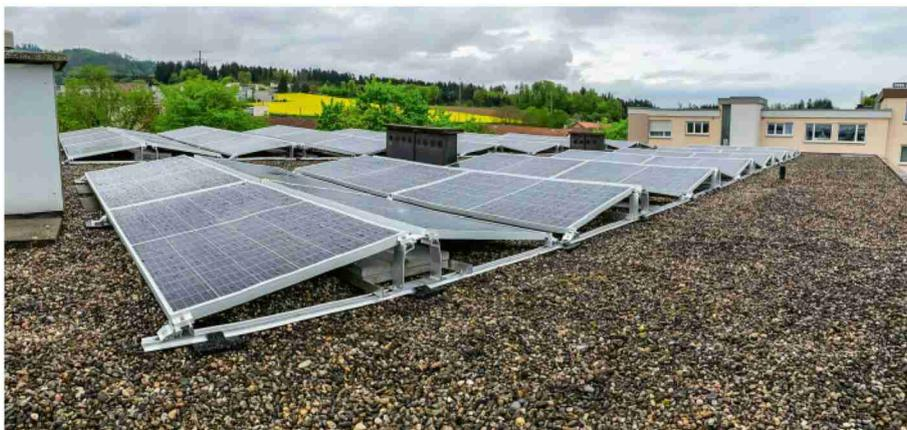
**Grâce à l'autoconsommation, ce système photovoltaïque est rentabilisé en 16 ans. Sur sa durée de vie, cela se traduit par un rendement d'un peu moins de 2,5 %.**
