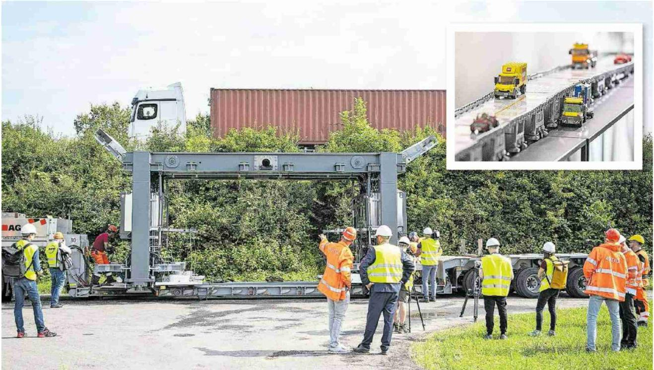
Das erste Portal (oben die abgeklappten Leitplanken) wurde gestern auf einem LKW nach Rothrist transportiert. Im kleinen Bild ein Lego-Modell der «Astra-Bridge»: Oben rollt der Verkehr, unten wird gebaut.
