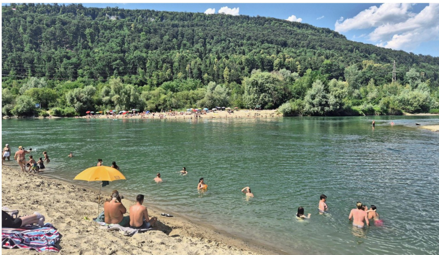
Sie sind bei Sommerhitze ein beliebter Ausflugsort: die Sandbänke unterhalb des Alpiq-Kraftwerks Ruppoldingen auf Rothrister und Boninger Seite.
