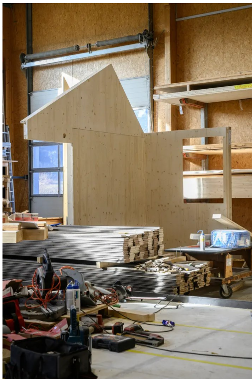
Das Tiny House wird in vier Wochen zusammengebaut. Foto: Franziska Rothenbühler
