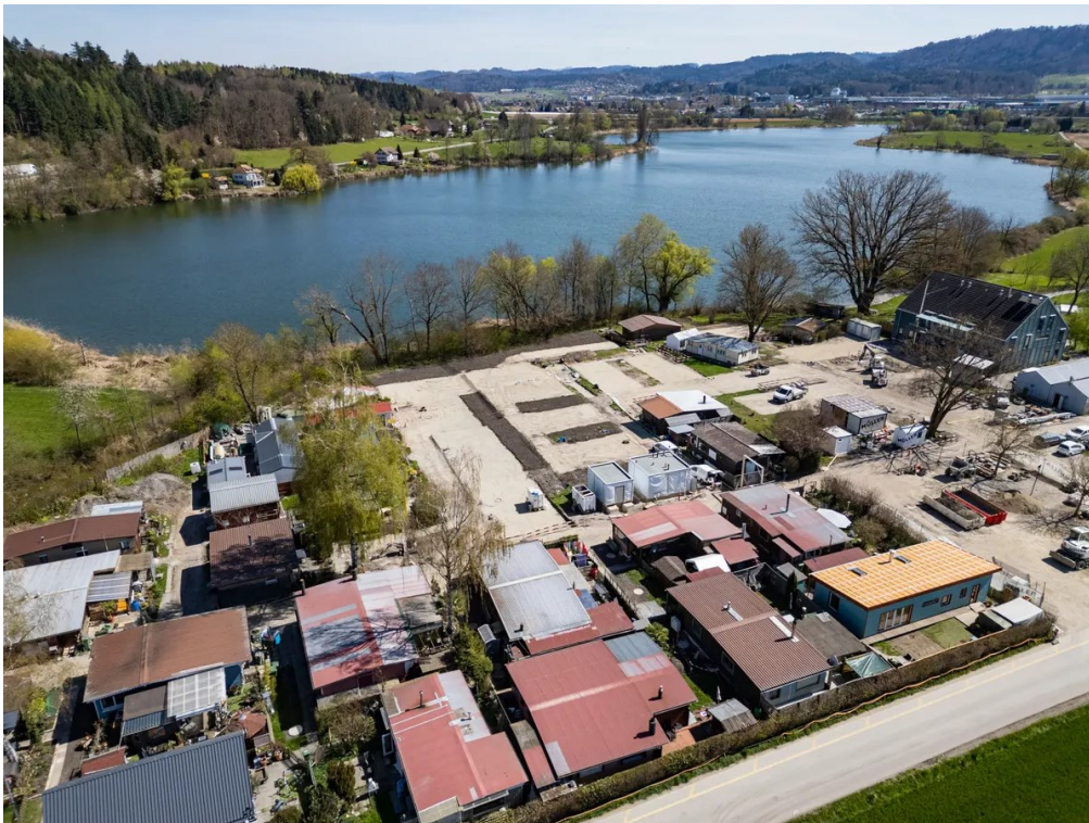
Auf den früheren Saisonplätzen (Bildmitte) werden die Fundamente für die Tiny-House-Siedlung am Moossee gelegt. Foto: Raphael Moser
