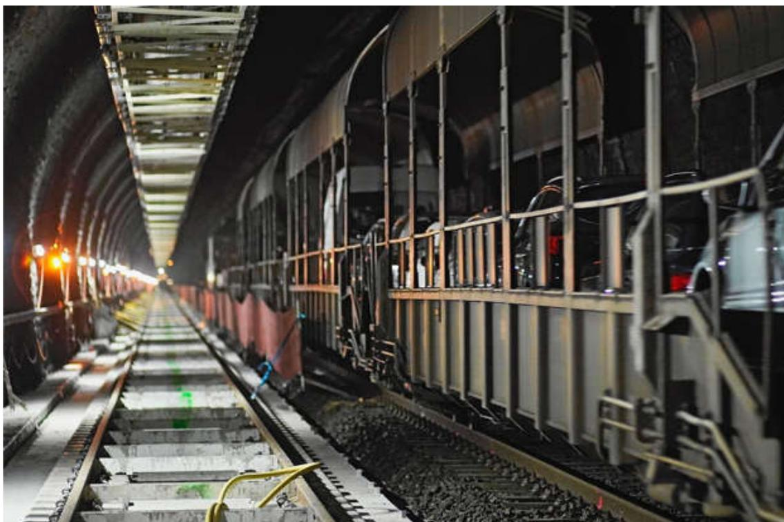
© Foto: PD Während rechts der Autoverlad von Kandersteg nach Goppenstein VS fährt, wird links das Schottergleis durch eine Betonfahrbahn ersetzt. Das kostet 75 Millionen mehr als anfänglich budgetiert.
