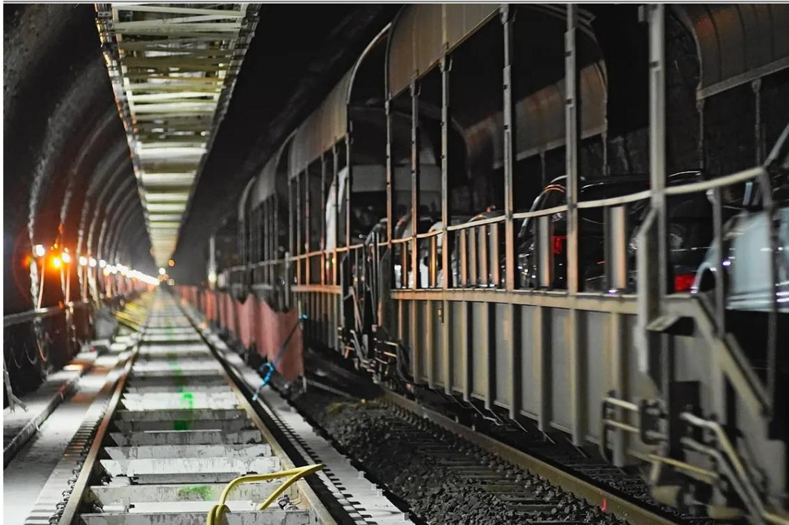
Während rechts der Autoverlad von Kandersteg nach Goppenstein VS fährt, wird links das Schottergleis durch eine Betonfahrbahn ersetzt. Das kostet 75 Millionen mehr als anfänglich budgetiert. Foto: PD
