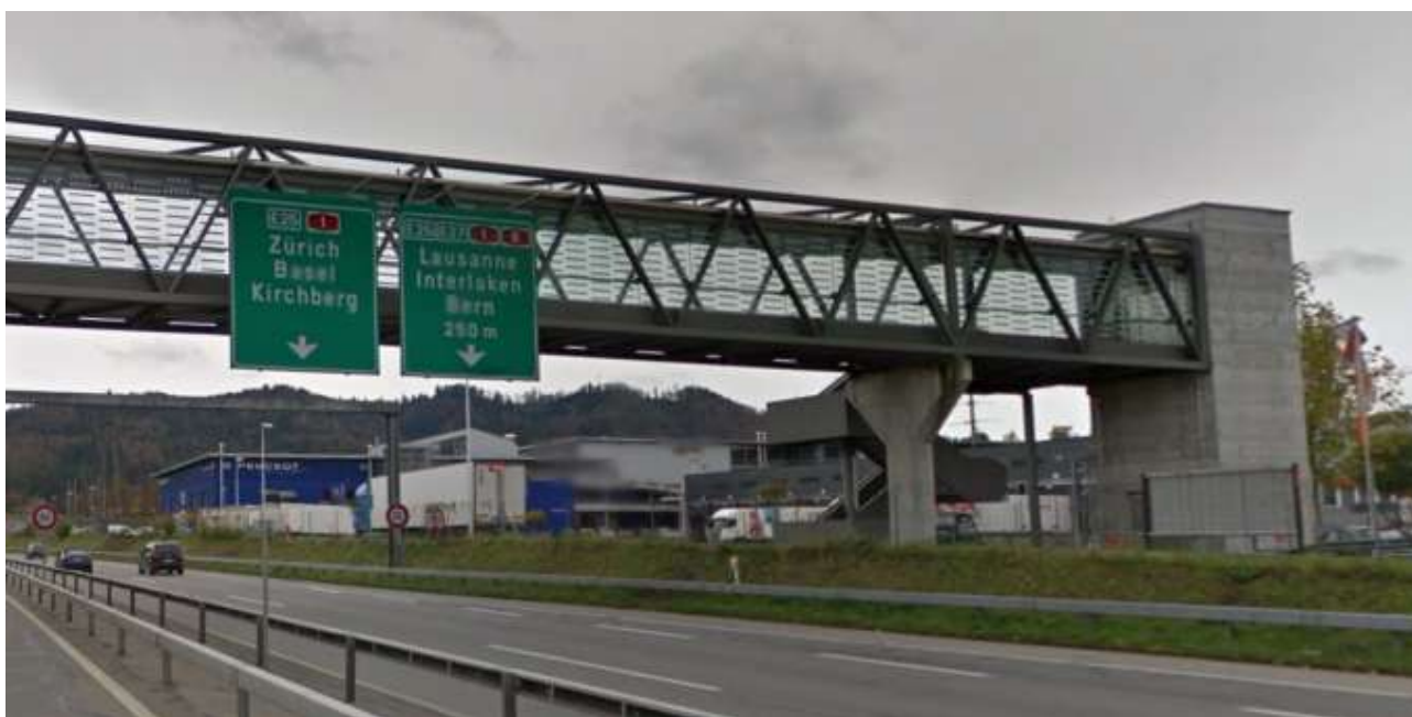
Die Fussgängerbrücke beim Shoppyland-Parking. - Screenshot Google Maps
