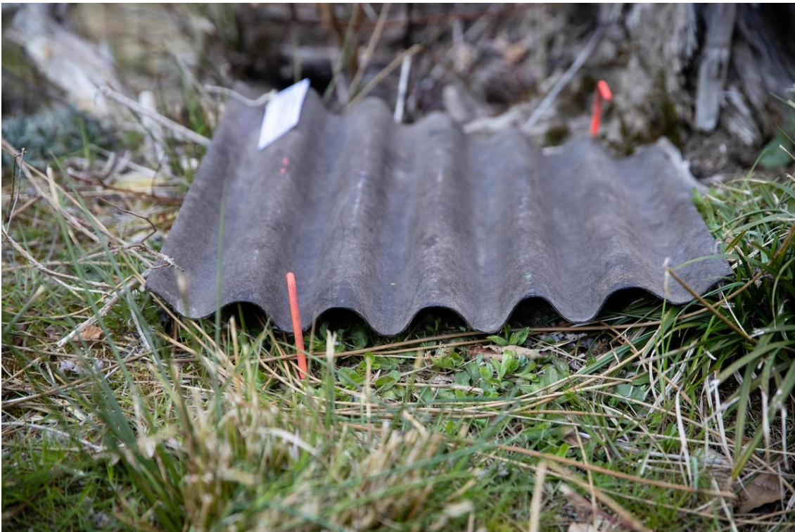
Bitumenplatte mit typischer Wellung.Foto: Nicole Philipp
