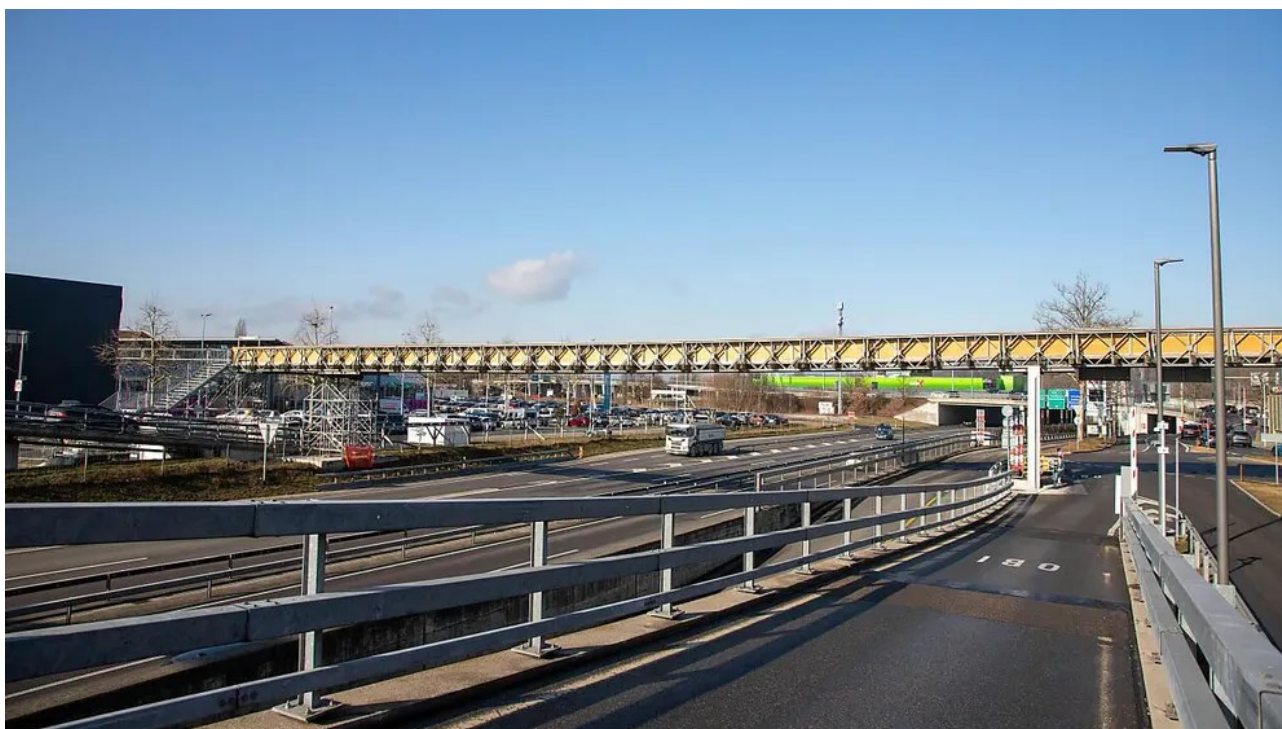
Die temporäre Fussgängerpasserelle über die Autobahn A6 bei Schönbühl.
