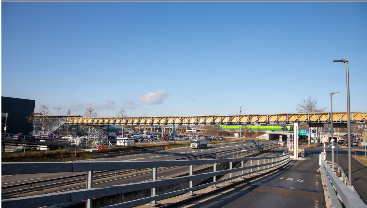
Die temporäre Fussgängerbrücke über die Autobahn A6 in Schönbühl wird ersetzt. (Bild: ASTRA)
