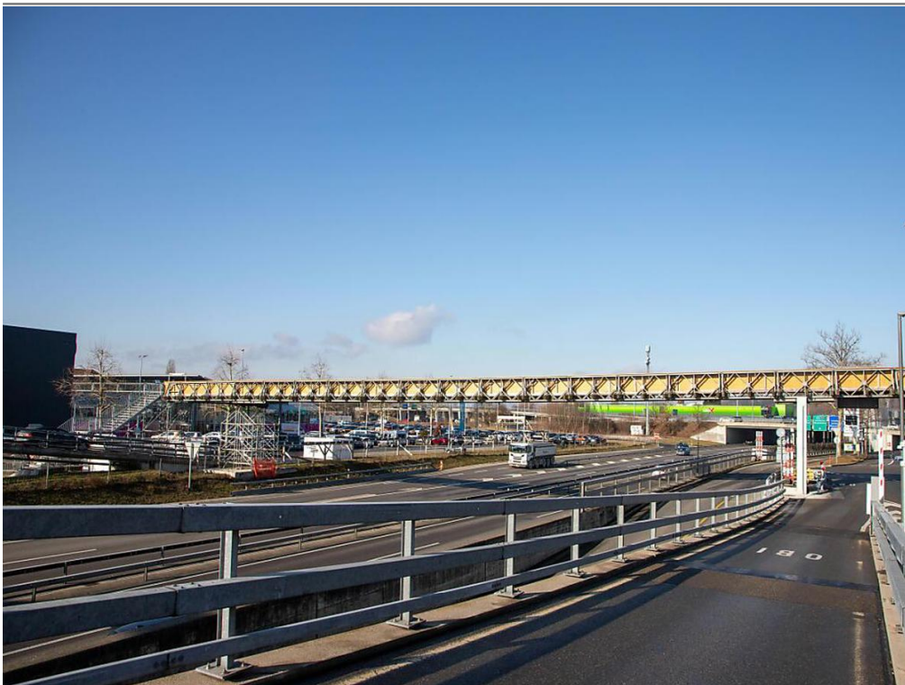
Die temporäre Fussgängerpasserelle über die Autobahn A6 bei Schönbühl.Foto: zvg/Astra
