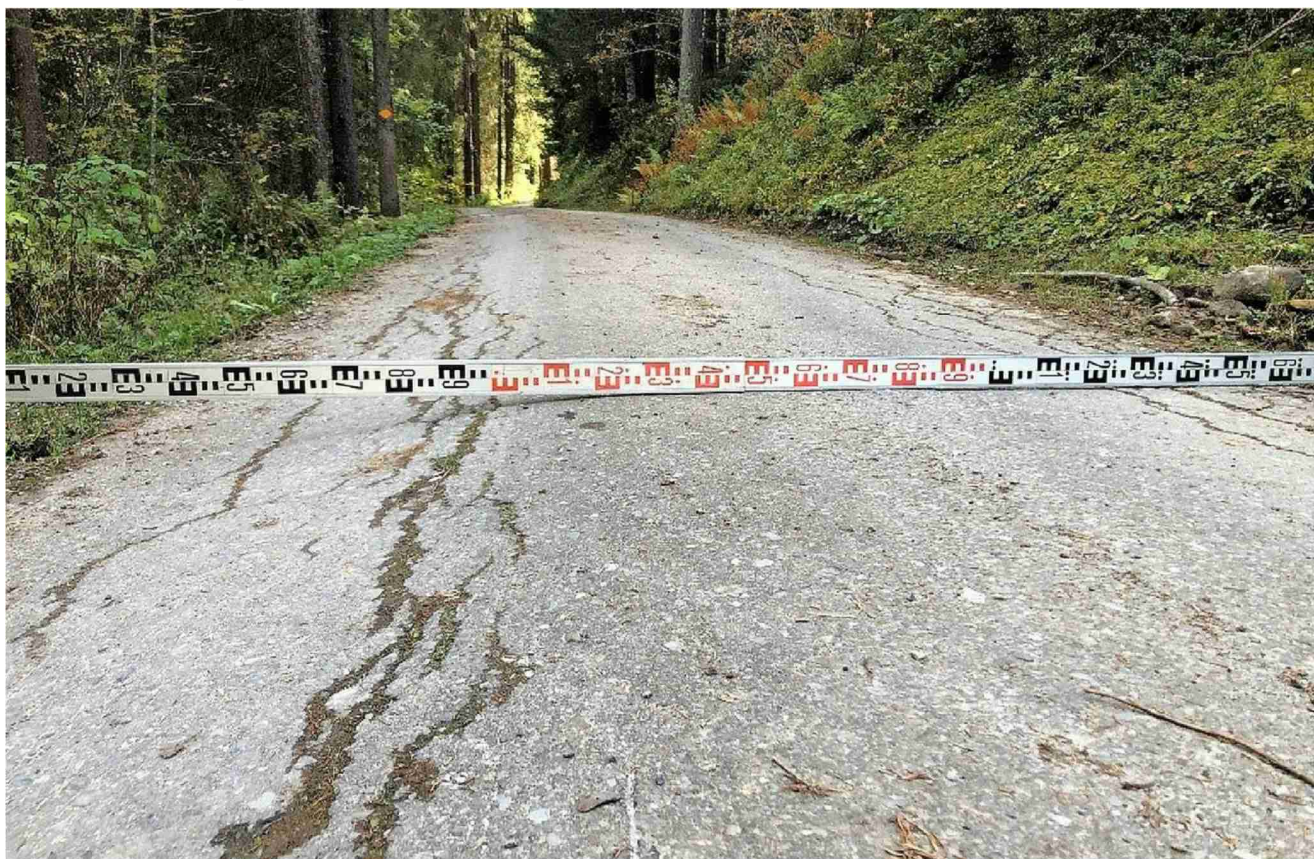
Die Traubachstrasse in Habkern. Unter anderem im Gebiet zwüsche Gräbe ist die Strasse in keinem guten Zustand. Foto: Sibylle Hunziker
