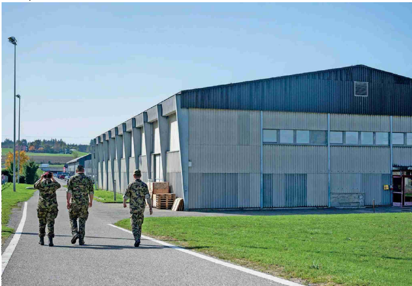
In der Mehrzweckhalle des Waffenplatzes Sand soll vorübergehend eine Asylunterkunft entstehen.
