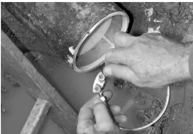
Der sichtbare Chromstahling im Innern des Rohres verhindert das Ausfransen des Liners durch den Wasserfluss
