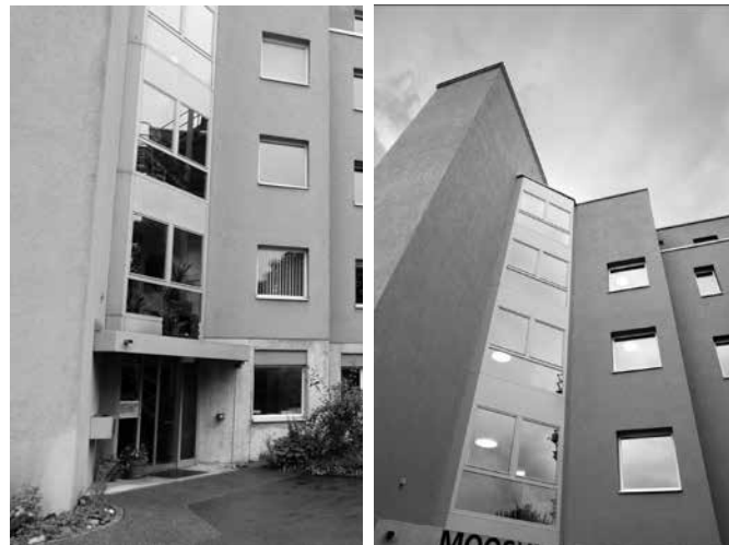
Die Fassade wurde neu gestrichen, Türen und Fenster saniert und teilersetzt
