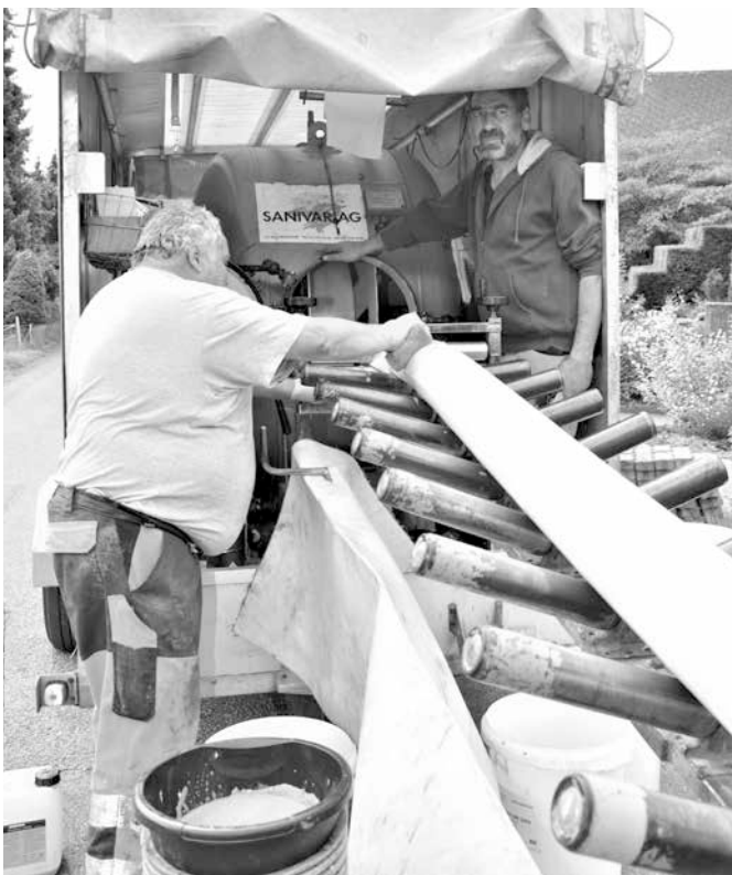
Martin bestreicht mit synthetischem Öl (trinkwassertauglich) den Liner, damit er gleitfähig wird
