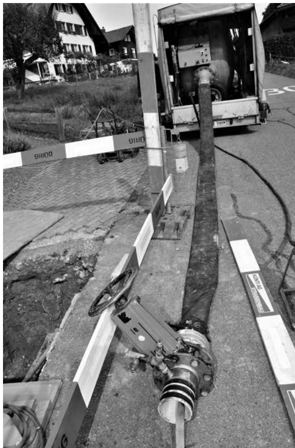
Der Anhänger mit dem Druckbehälter und inwendigem Haspel wird vor dem Graben positioniert. Sichtbar auch der 6 m lange Druckschlauch mit der speziellen Konstruktion, Schieber und Rohrstück zur Befestigung des Liners
