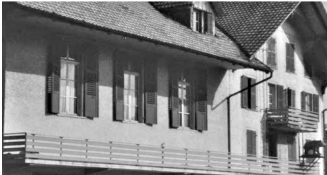
An den drei grossen Fenstern wurden die «Läden» geschlossen, um den Saal zu verdunkeln
