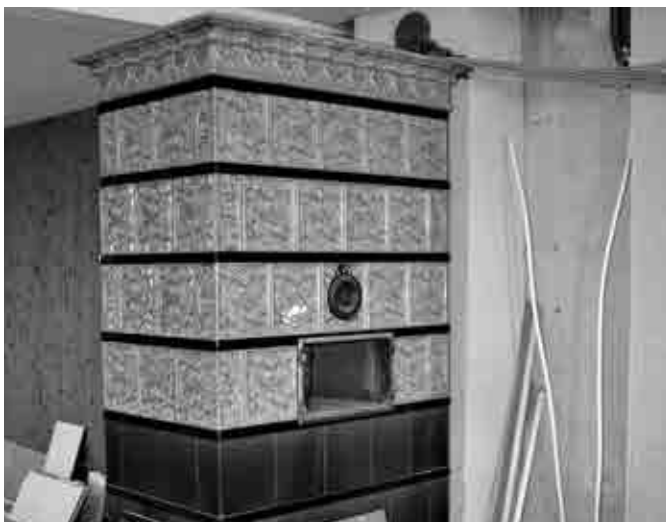
Der alte Kachelofen wurde abgerissen
