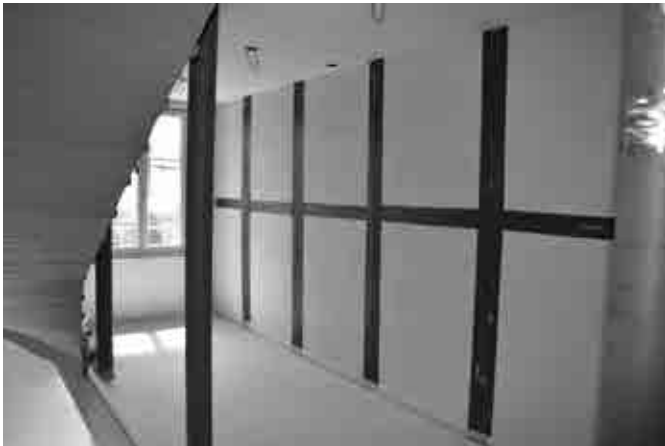
Gang mit sichtbaren alten Balken
