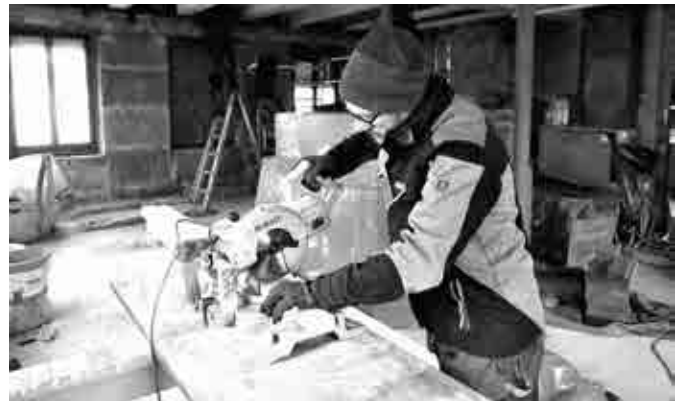
Arbeiten mit der Handkreissäge
