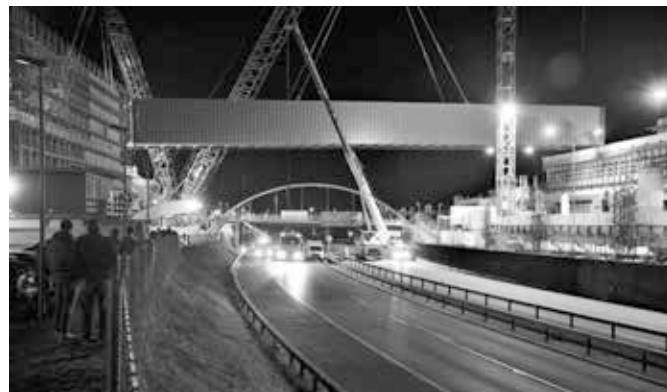
Nun hat die Brücke die richtige Position erreicht und kann auf die Träger abgesenkt werden
