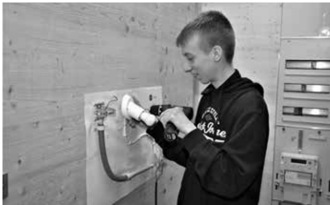
Loic Stucki aus Herzogenbuchsee montiert die Schrägfassung
