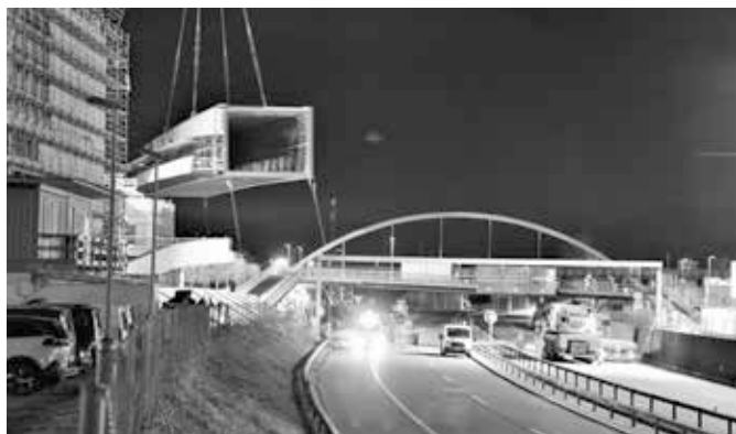
A6 total gesperrt, der Brückeneinbau hat begonnen
