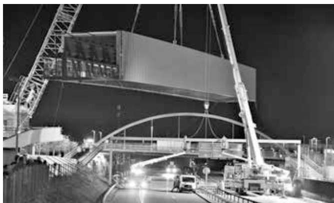
Die Brücke schwebt jetzt über der Autobahn
