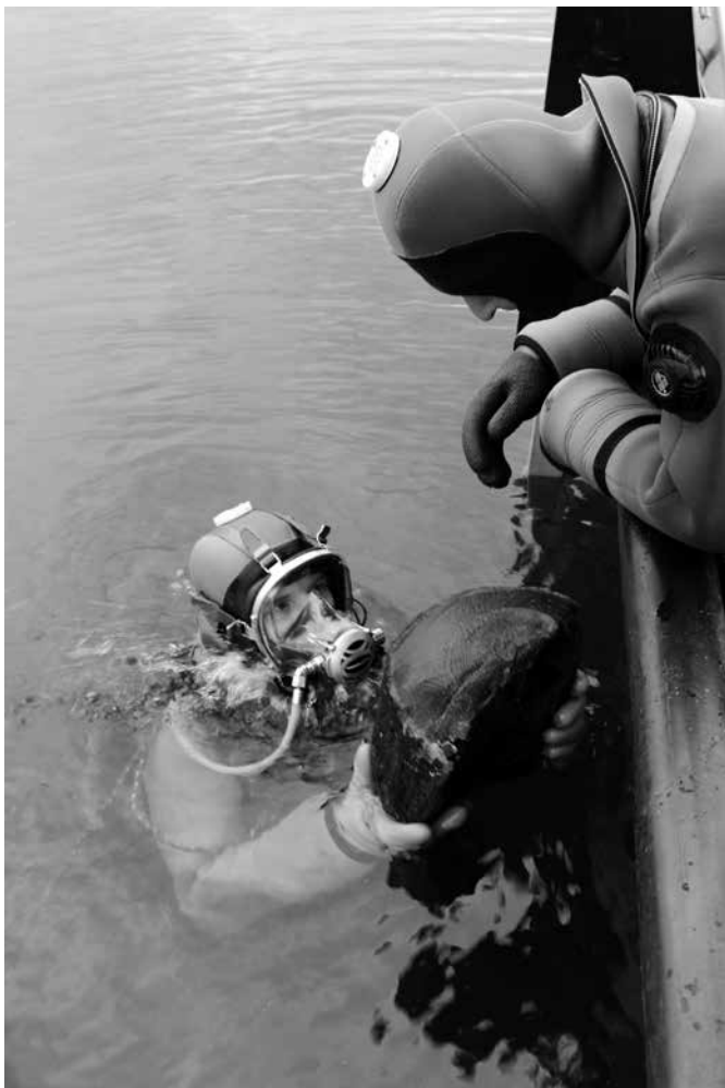
Ein beprobter Pfahl wird zum Boot gebracht
