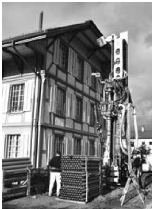
Der imposante Bohrturm vor dem Alten Schulhaus
