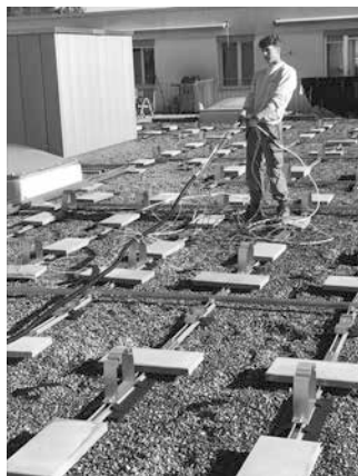
Installation der Verkabelung
